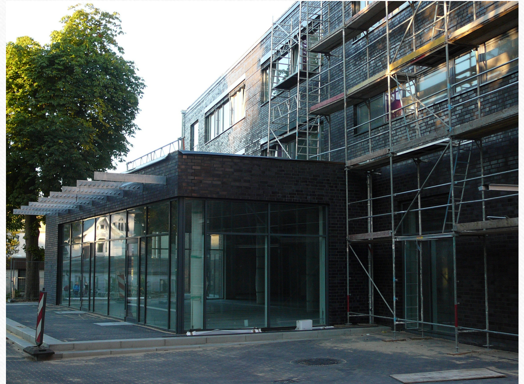
Neubau mit Mensa (kurz vor Fertigstellung)
